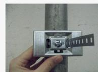
2. Die Schraube anziehen, damit das Band gespannt wird und der Halter am Rohr hält.
