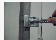
3. Die überstehenden Reste des Spannbandes entfernen und die Kunststoffabdeckung mit dem Schild wieder aufstecken.
